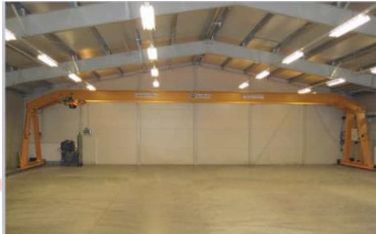
6,3 t-ás beltéri bakdaru maximális helykihasználással
