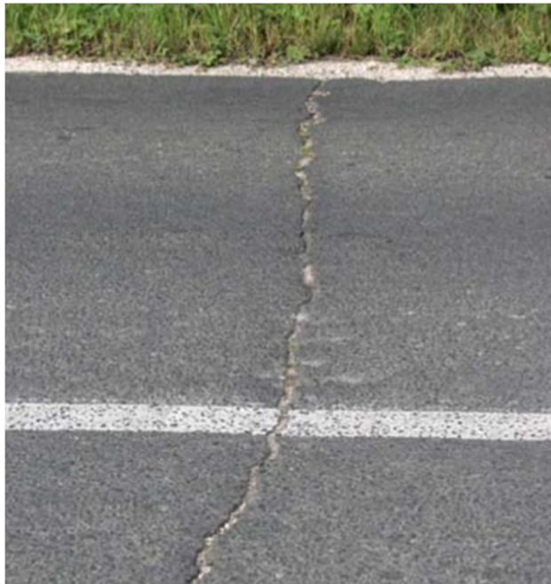
Keresztirányú repedés
