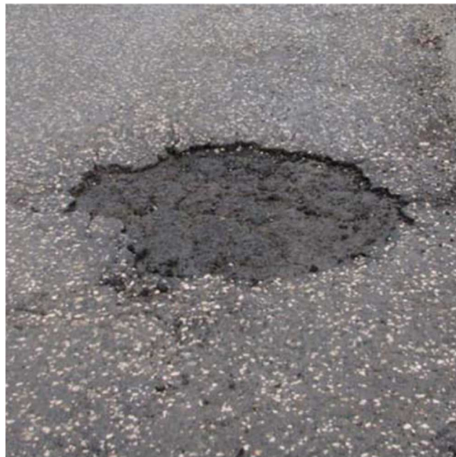
Kopó- és kötőréteg leválása
