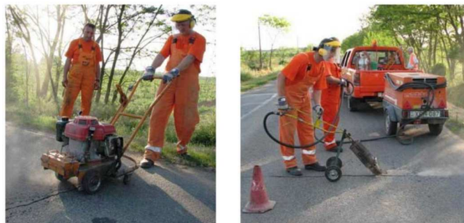
Repedés felbővítése gépi marással és kitisztítása
