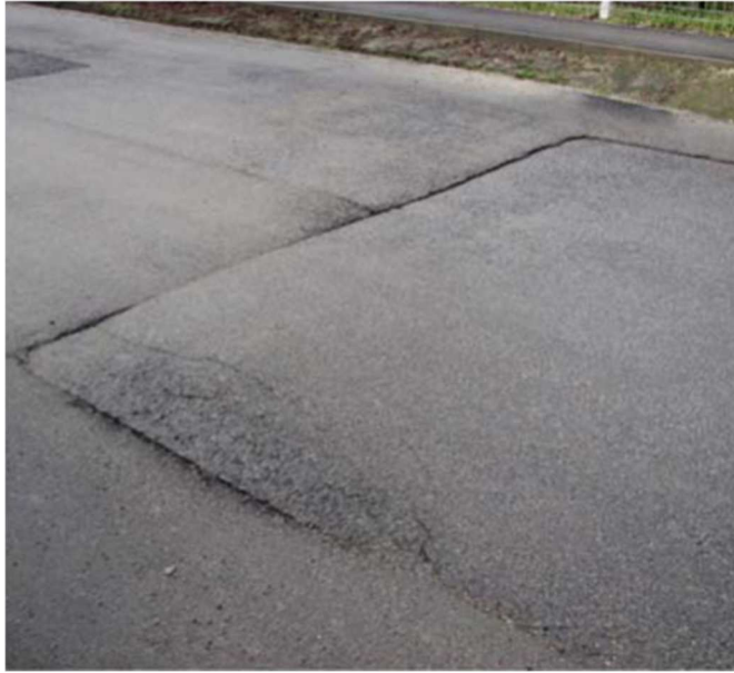
Burkolatjavítás összedolgozási hibája
