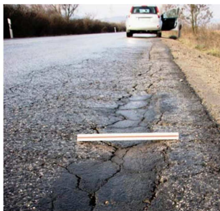
Szabálytalan repedésrendszer megsüllyedt pályaszerkezeten
