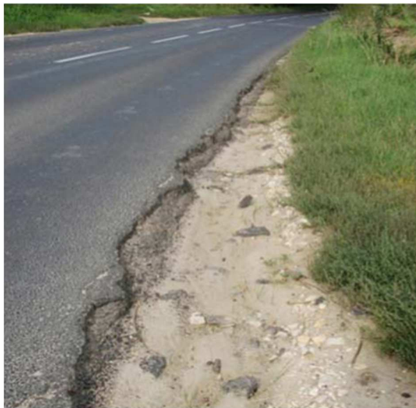
A burkolat szélének letörése
