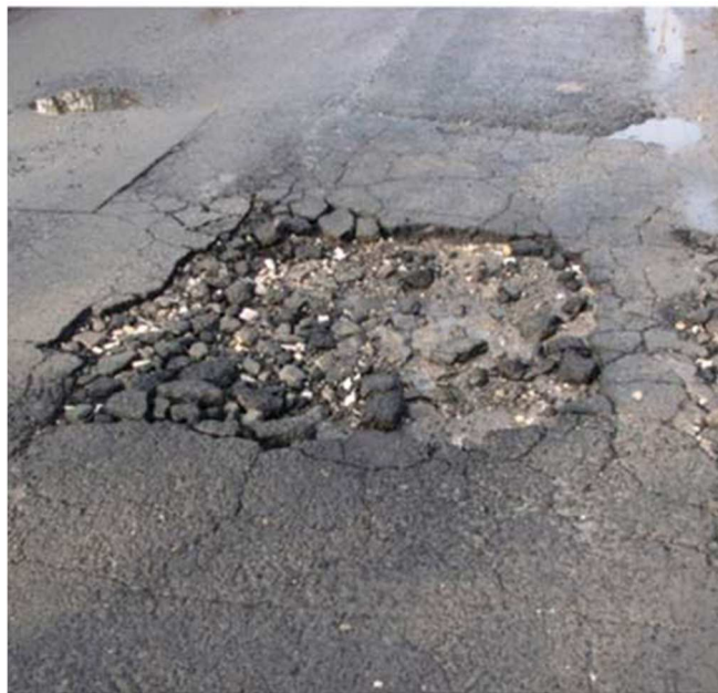
Sekély kátyú képződés makadám alapú aszfaltburkolaton
