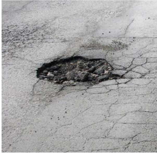
Mély kátyú képződés a kötőréteg megbomlásával
