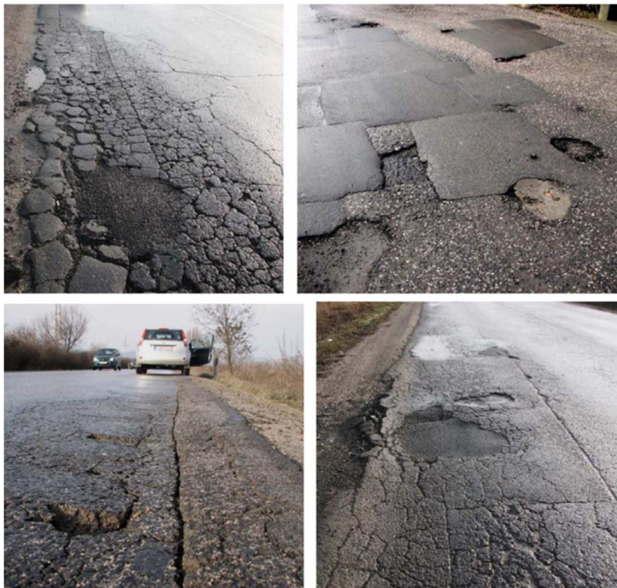
A szakszerűtlen javítás újabb burkolathibákat okozhat
