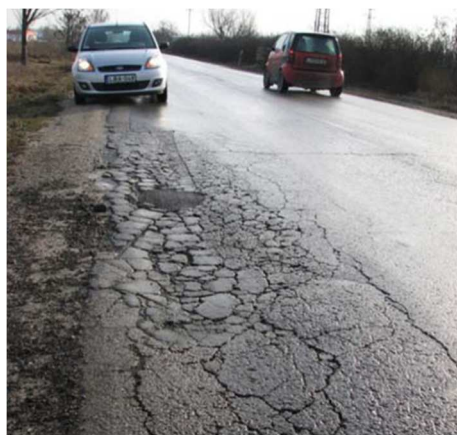
Szabálytalan repedésrendszer megsüllyedt pályaszerkezeten
