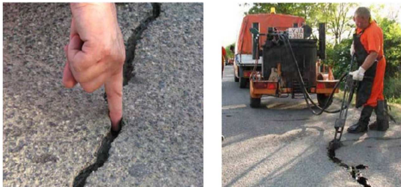
Kitisztított repedés és kiöntése fugamasszával
